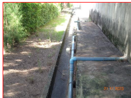
ภาพที่ 2.3-18 ท่อรวบรวมน้ำฝนปนเปื้อน บริเวณลานเก็บกองวัตถุติด
