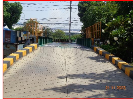
ภาพที่ 2.3-20 เครื่องซั่งน้ำหนักรถบรรทุก
