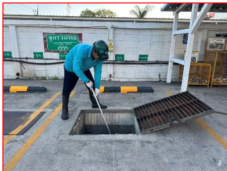
ภาพที่ 2.3-15 พนักงานทำความสะอาด บ่อดักน้ำมันและอูมิเนียม (Oil & Sand Trap)
